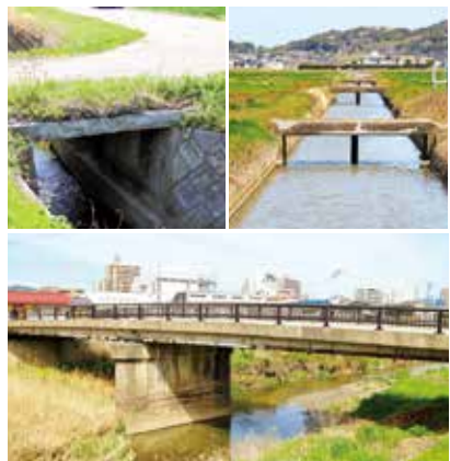
▲令和4年度は市内全280橋の道路橋梁のうち、68橋の点検・補修を実施
