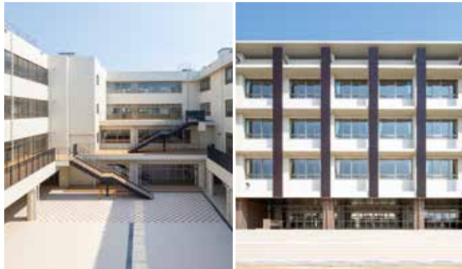
▲3月に完成した福岡中学校の中庭（左）と運動場から見た校舎（右）。引き続き給食棟の増築工事などを実施
