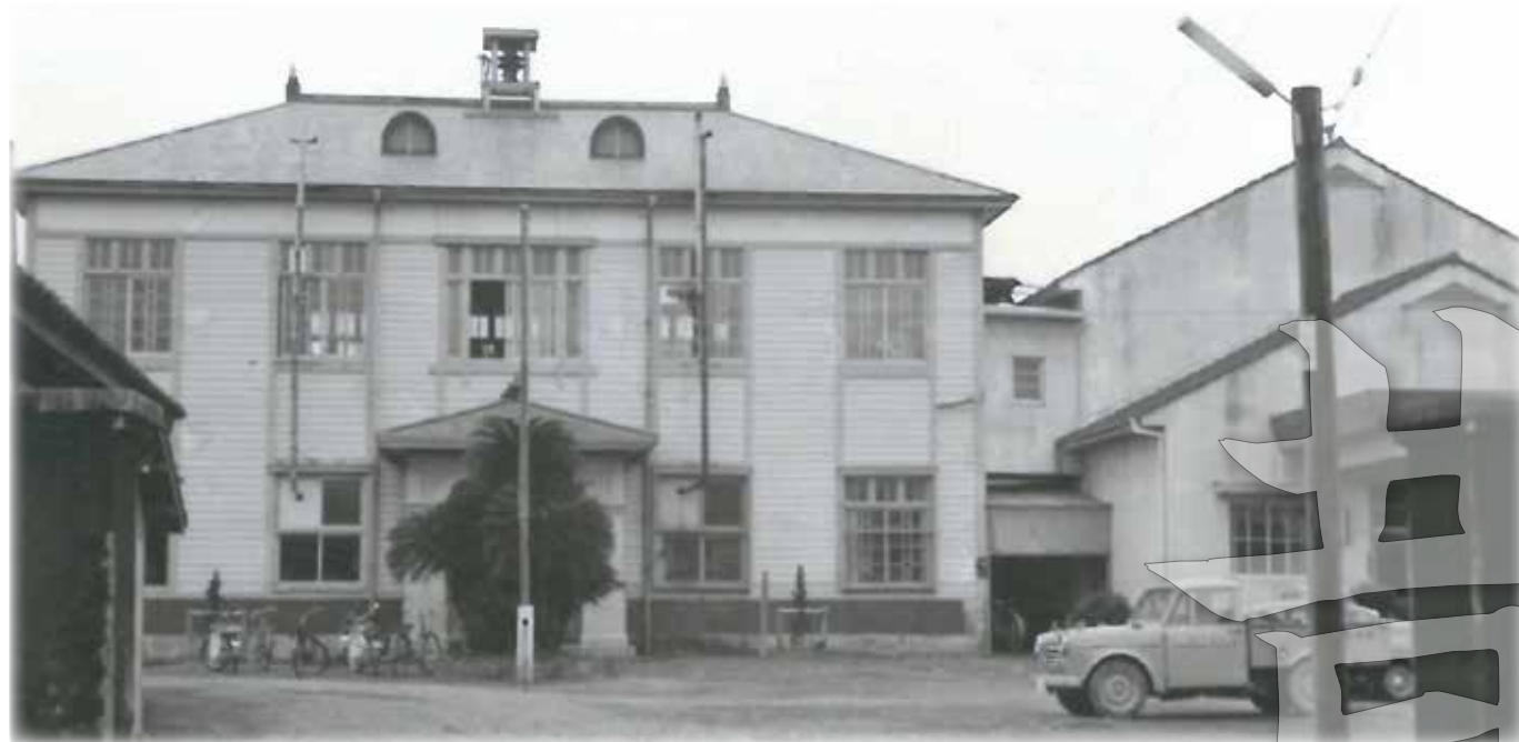
▲昭和4年、現在の福間体育センターの場所に建設した福間町役場庁舎。現在の市役所庁舎の場所に新庁舎を建設した昭和57年には、建物の老朽化が進み、あちらこちらに損傷があったといいます
