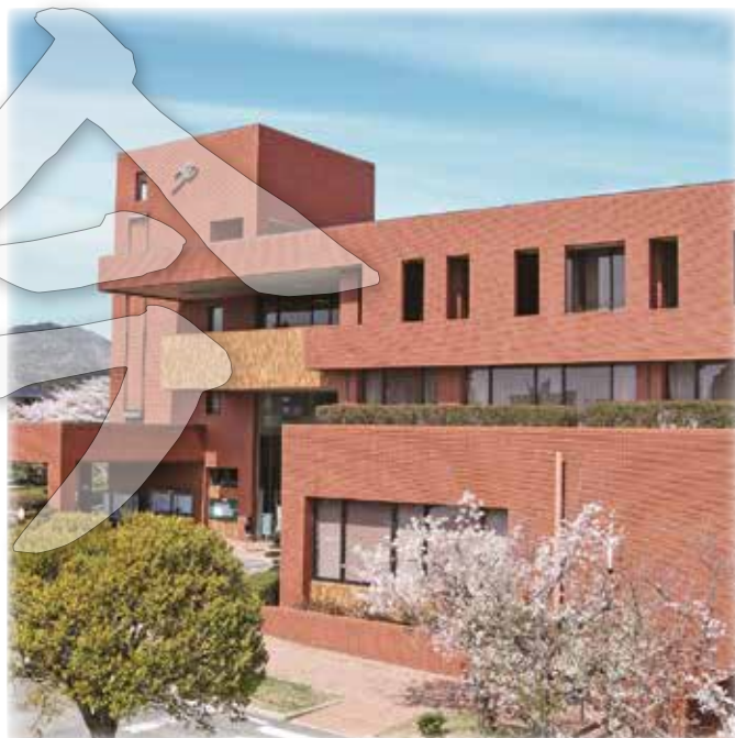
▲平成17年の福間町と津屋崎町の合併後、福津市役所福間庁舎として、また、平成28年に別館を増築し、津屋崎庁舎を統合しました
