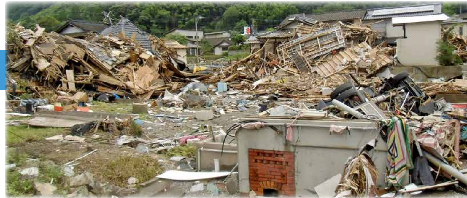
▲令和 2 年 7 月豪雨で浸水し倒壊した熊本県球磨村の家屋【写真提供(一財)消防防災科学センター「災害写真データベース」】
