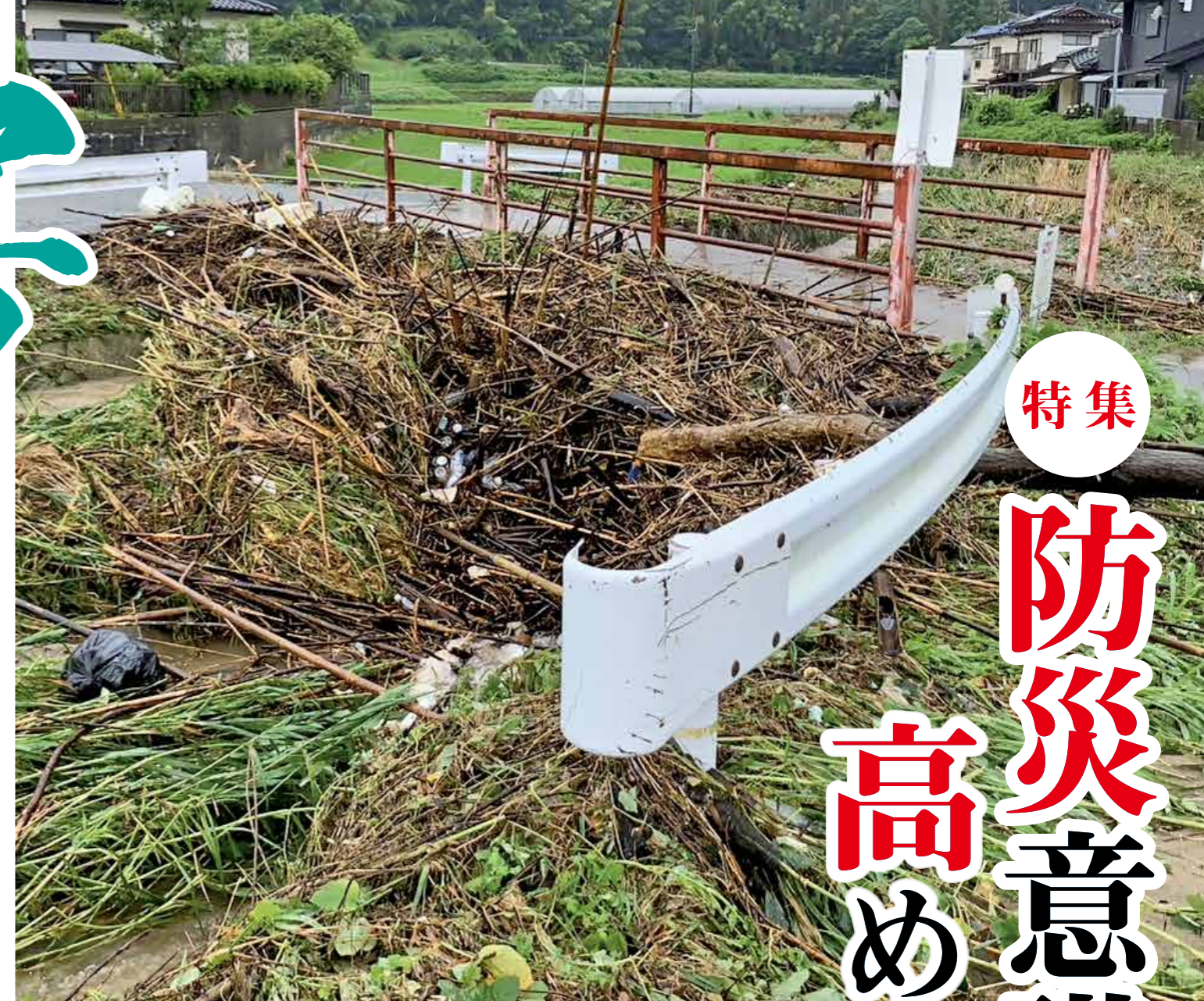
▲橋の欄干に草木が蓄積し、水がせき止められたことで起きた昨年7月の本木川の溢水
