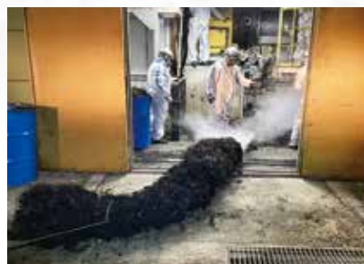
▲焼却炉内から取り除かれた金属の塊
