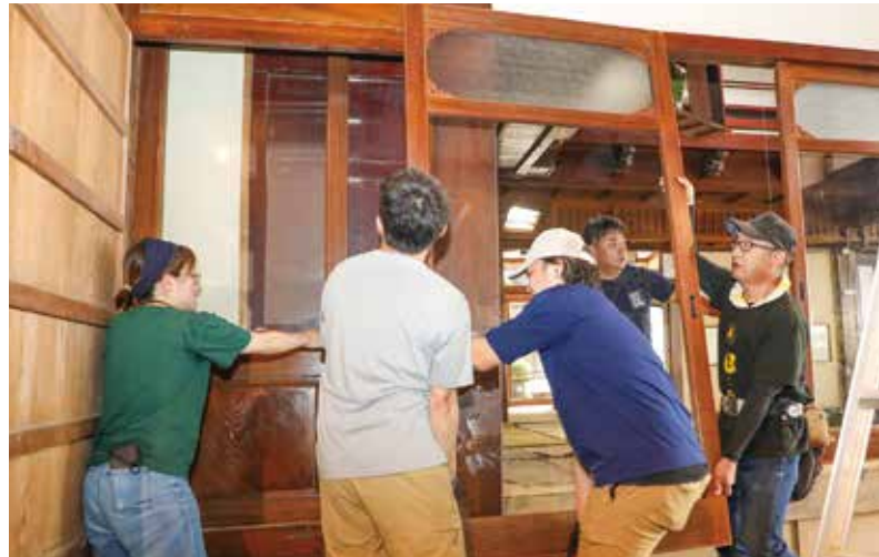
▲土間と居住空間の間の仕切りを取り外します
