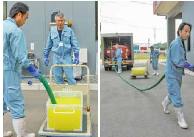
▲吸引実演とホースを伸ばす津屋崎サニタリーの職員
