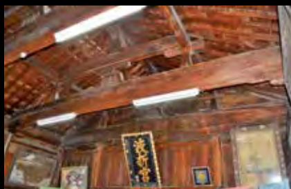
▲拝殿内部はあえて天井をつくらず、豪勢な二重虹梁を見せつけている
