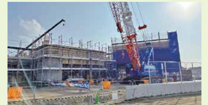
▲1階の工事が進む宮司小学校(仮称)
