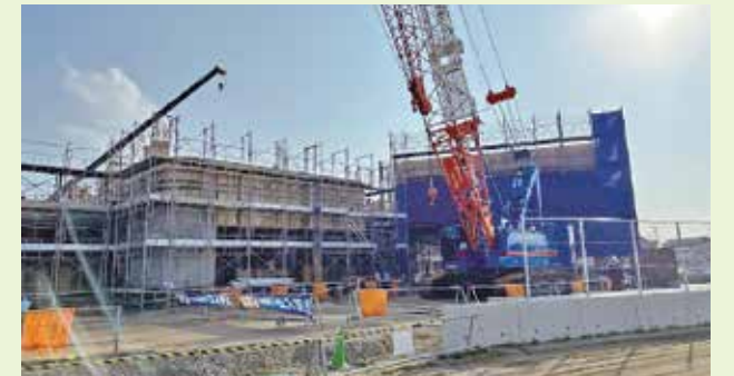
▲1階の工事が進む宮司小学校(仮称)
