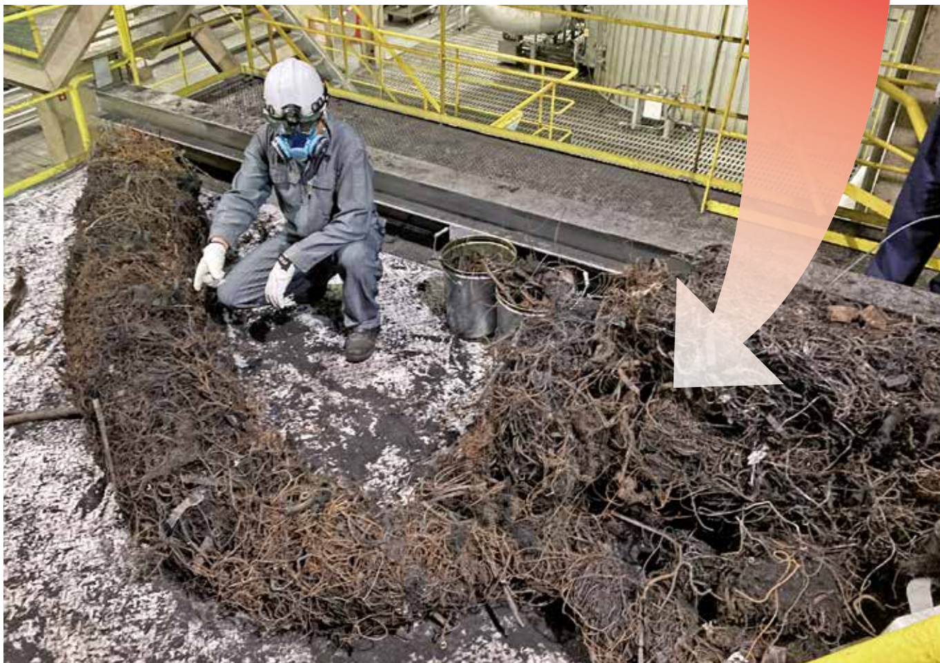
▲ごみ袋の中に混入した金属が、焼却炉内で直径40cm・長さ13mの塊になったもの
