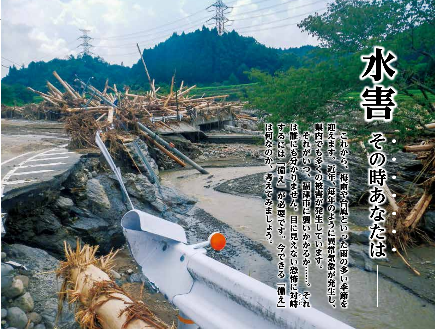
▲平成29年7月の九州北部豪雨で道路が崩落し、流木が押し寄せた朝倉市の黒川（朝倉市提供）
