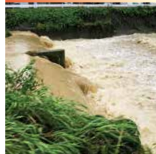
▲川は濁り、増水します。水路などにも近づかないようにしましょう
