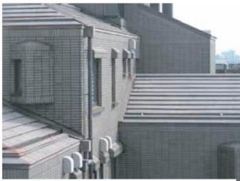
■道路の反対側に排水管を配置し、さらに壁面と同系色の塗装を施している。
