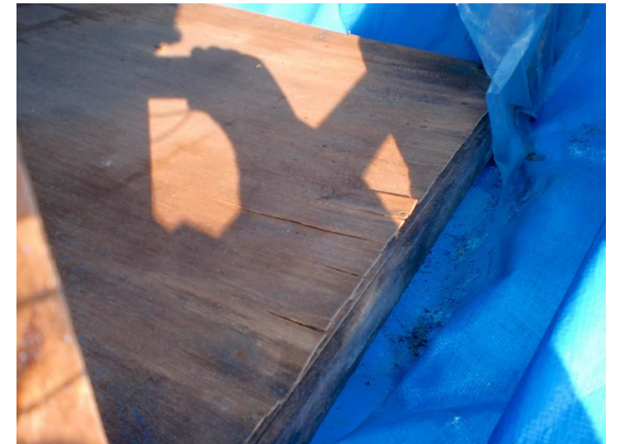
工作台地板の状態
