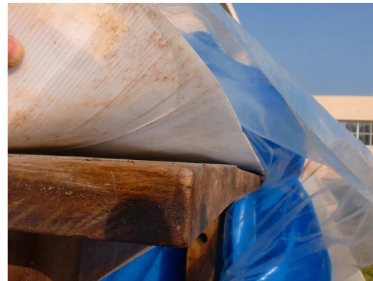
工作台天板の状態
