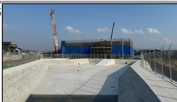
造成工事・建設工事実施状況（令和8年3月末時点）
