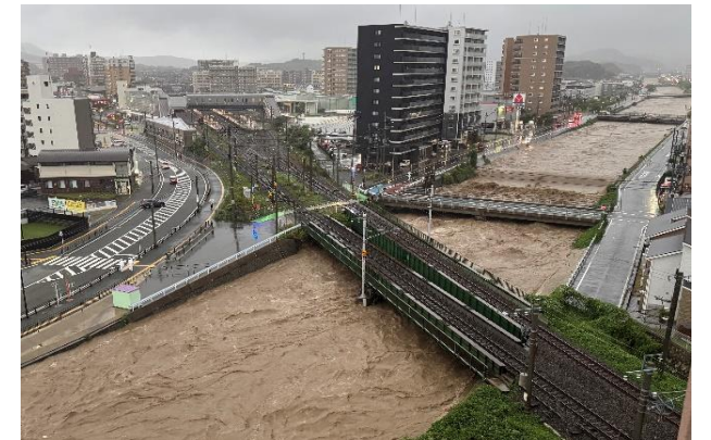
▲鞍手県道踏切付近
