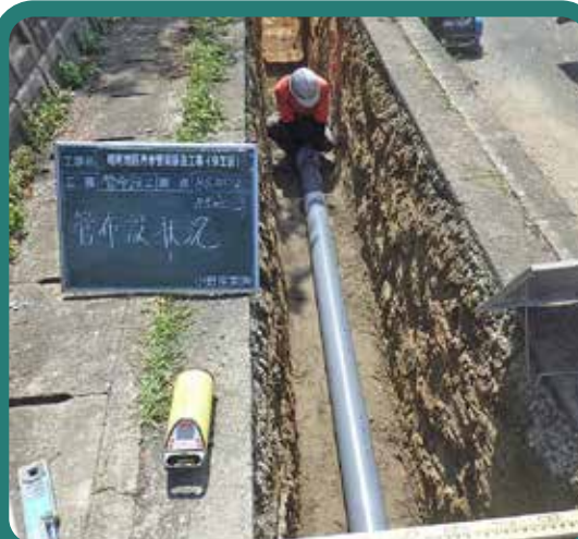
▲汚水管渠築造工事の管を敷設している状況
