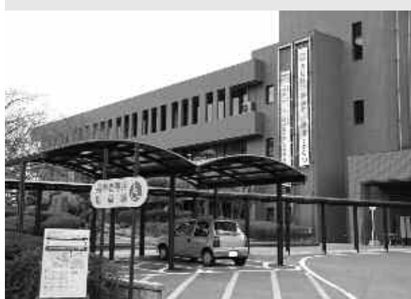
▲車いす使用者駐車場
