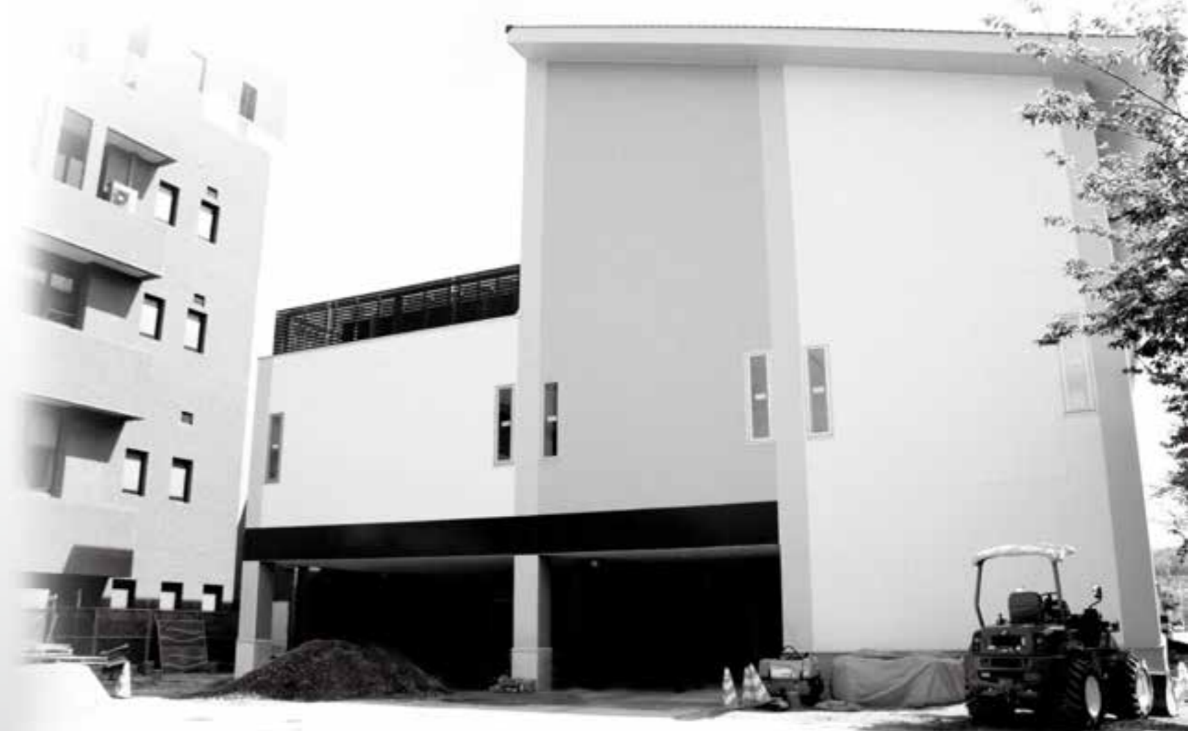
▲福間庁舎では6月13日(月)の庁舎統合に向けて工事が進められています。
