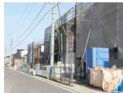
▲住宅の建設が進む西福間5丁目
