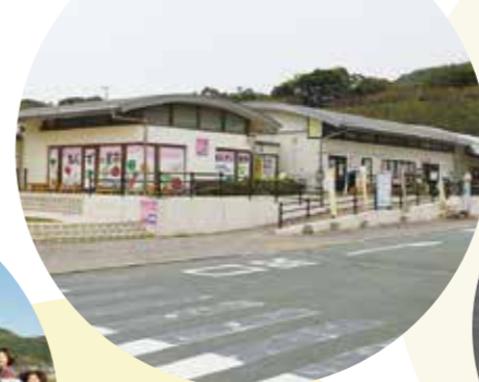
▲地方創生拠点整備事業 (あんずの里市改修工事委託料) 2億310万円
