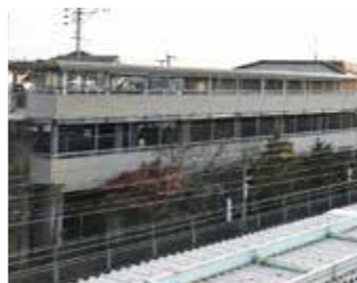
⑦現在1階部分は使われていない立体駐輪場
