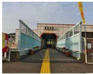
②神興・神興東地域につながる東福間駅の高架橋
