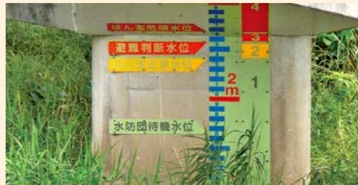
▲西郷川の四角橋に設置している水位板
