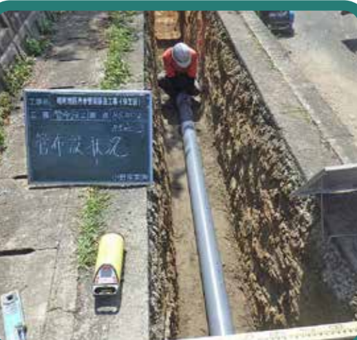
▲污水管渠築造工事の管を敷設している状況
