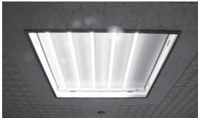
▲庁舎内の蛍光灯約1,100本中700本をLEDに変更しました
