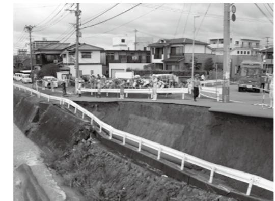
▲昨年9月4日降り続いた雨による西郷川の護岸崩落
