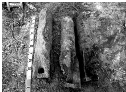
▲工事現場で見つかった不発弾。羽がついています
