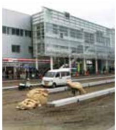
▲平成 22 年 2 月 27 日、J R 福間駅の新駅舎が完成
