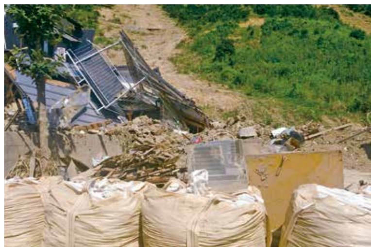
▲土砂崩れで倒壊した宇和島市吉田地区の家屋
