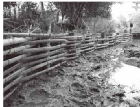
▲近くで伐採した竹を使って、見事に組み上がったシガラミ
