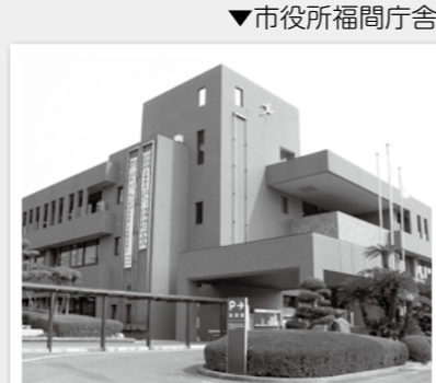
▼市役所福間庁舎
