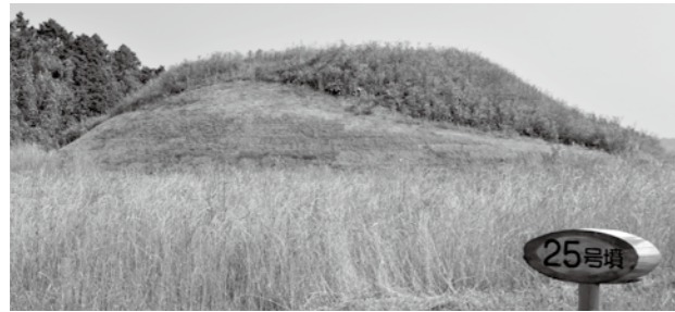
▲工事後の25号墳
