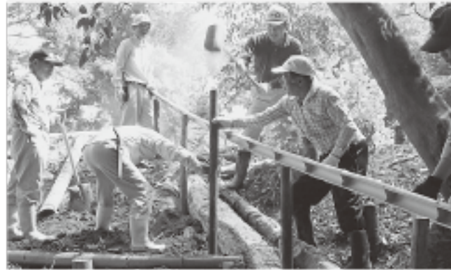
▲手すりを支える柱を力いっぱい打ち込みます
