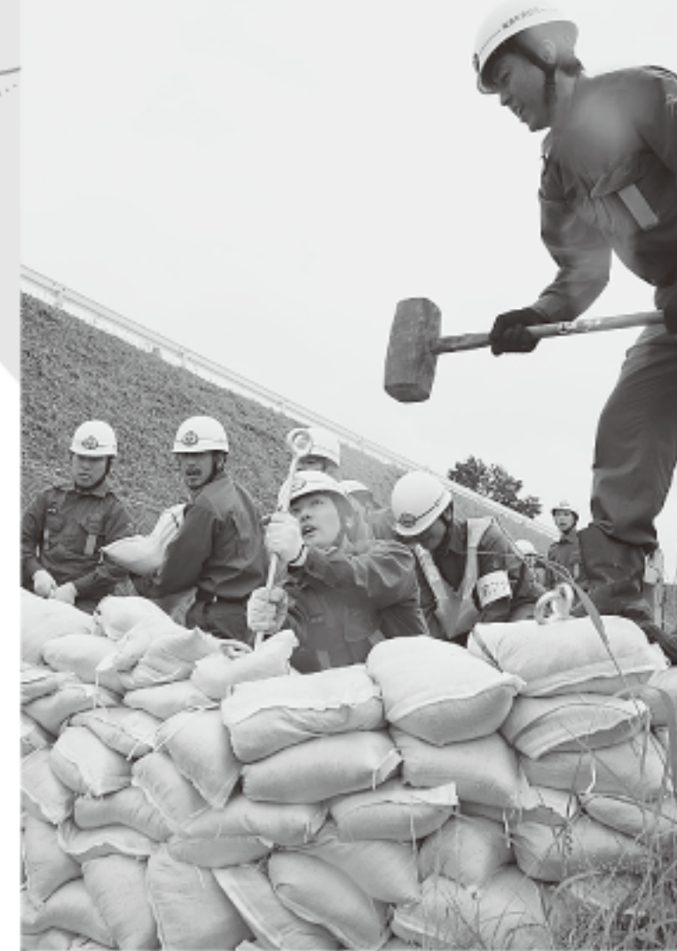
▲雨が降りしき中、ずっしりと重くなった土のうを懸命に積み上げる消防団員
