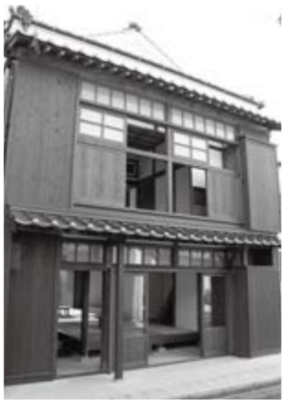
▲築90年の津屋崎千軒古民家
