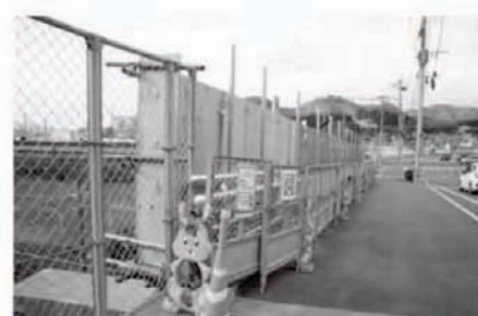
▲工事をしている光陽台跨線橋
