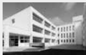
▲福間南小学校の増築棟
