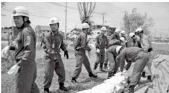
▲水の浸入を防ぐ土のう積み上げの訓練
