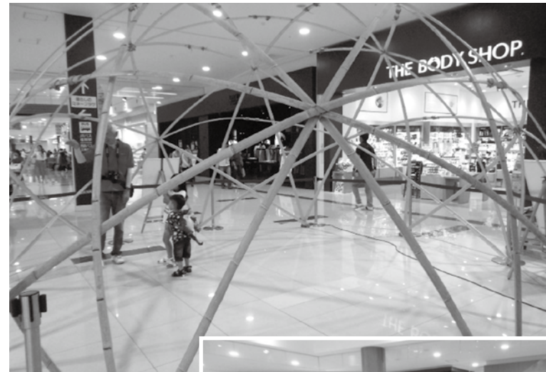
▲竹で組み上げたスタードーム
