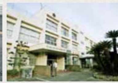
▲教室棟は1964年に、管理棟は1972年に建設の福岡小学校。老朽化が進んでいます
