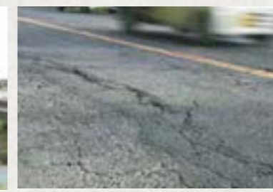
▲大型車がよく通るせいか、舗装が傷んでいる本木区から舎利蔵区へと続く道
