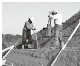
▲人力の突き固め作業
