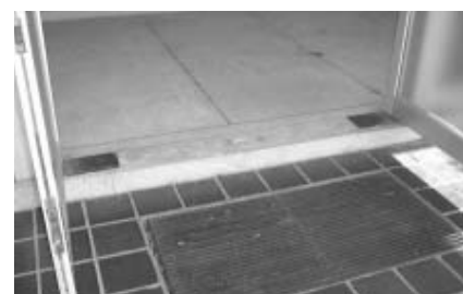
神興小学校(体育館出入口)
