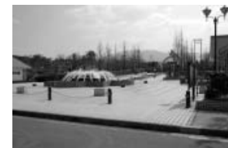
歩道と連続した開放的な出入口
