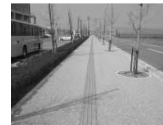
連続して敷設
