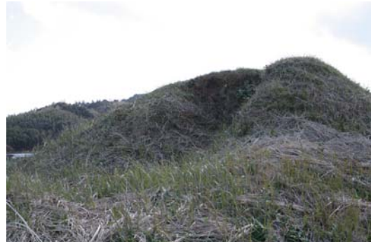
写真-12 新原・奴山 36 号墳 主体部分が陥没している
