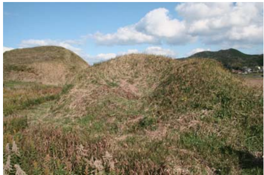
写真-11 新原・奴山 31 号墳 主体部分が陥没している
