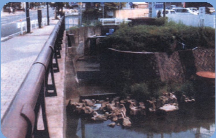
寺溝排水路の流入地点(平成12年6月撮影)
