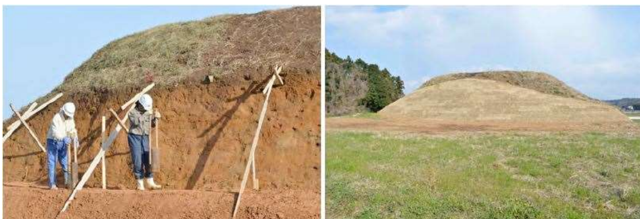
25号墳墳丘崩落部の復旧作業（左：修復作業[平成26(2014)年]、右：修復後[平成28(2016)年完了]）
