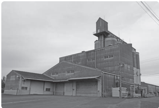
世界遺産内の津屋崎カントリー施設の解体は令和4年度予定
