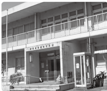
解体される津屋崎公民館
