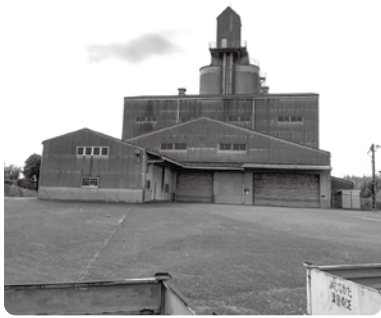
解体されるカントリーエレベーター
