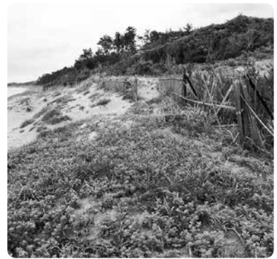
破損した竹柵と堆積した海砂
