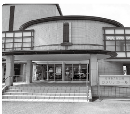
文化会館カメラアホール
