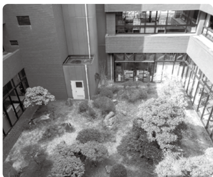
改修工事予定の庁舎本館中庭
