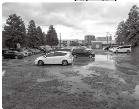
舗装工事予定のふくとびあ駐車場
