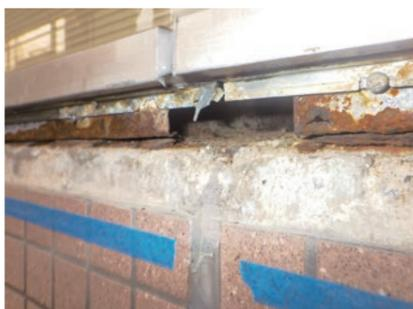
▲工事途中に発見された腐食箇所
