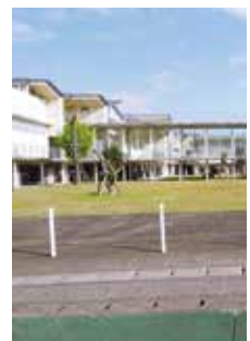
▲先進的な水害対策をした高床式の塩田中学校
