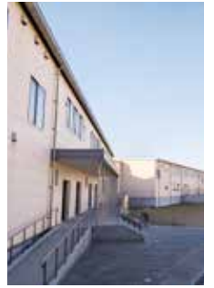
▲福間南小学校の増築された校舎
