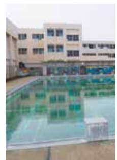
▲解体前の福岡南小学校のプール
