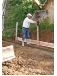
▲土砂の流入で塞がれた農業用水路の補修
